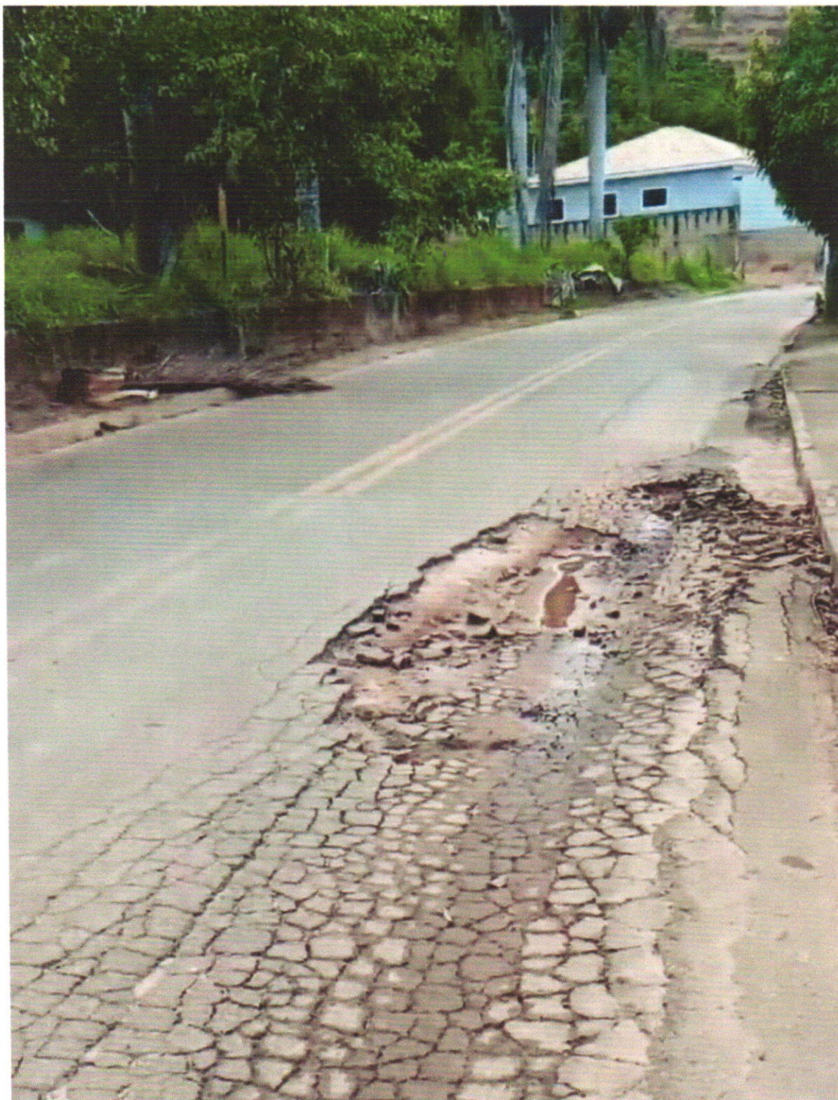
Fragmentação e formação de crateras no Pavimento
