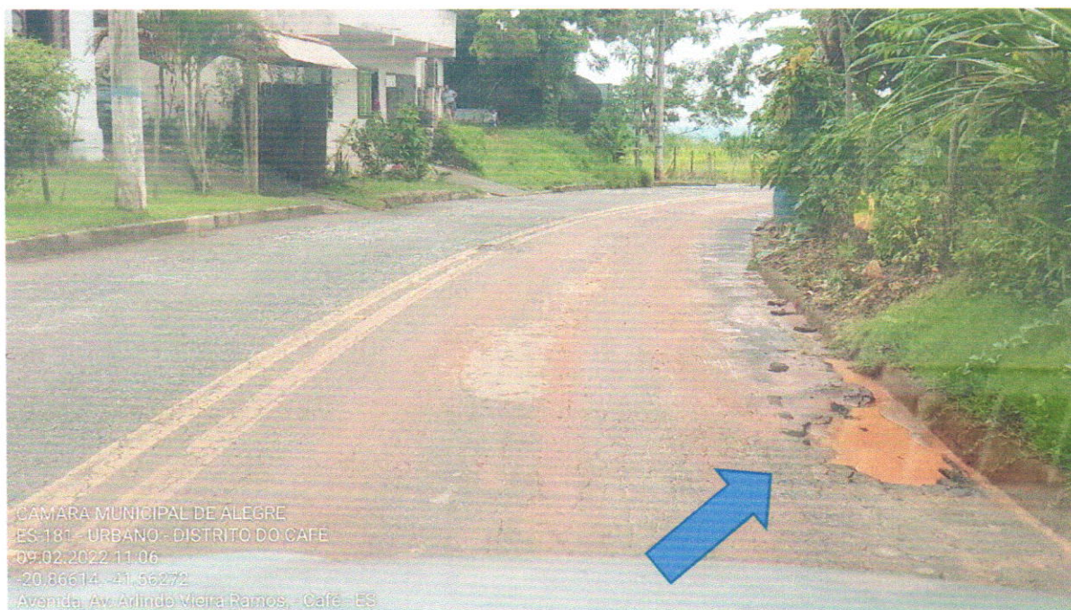
Defeito no Pavimento provocado pela falta de Drenagem Pluvial em todo o trecho
