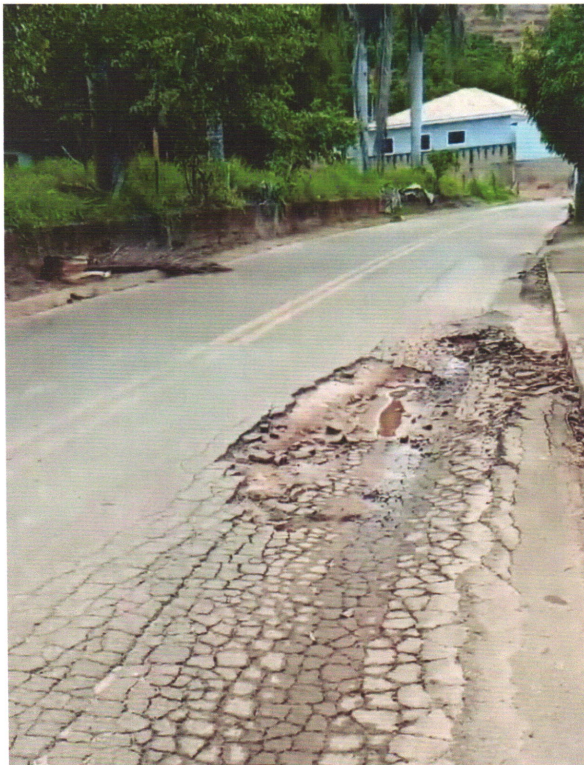
Fragmentação e formação de crateras no Pavimento
